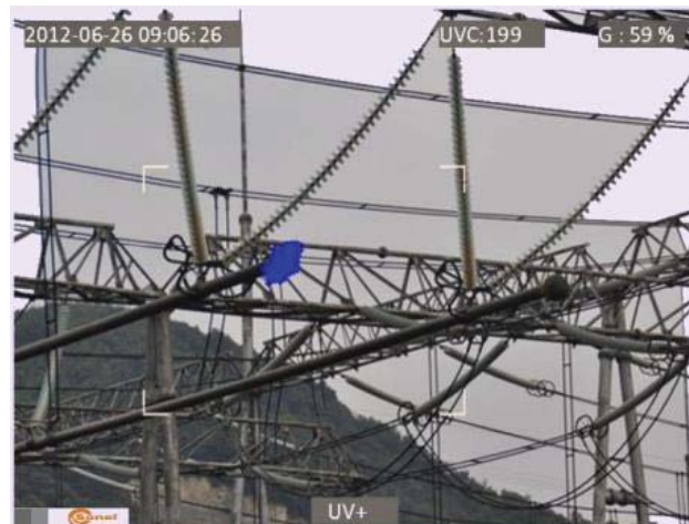
Рис. 5-8. Коронные разряды в реальных условиях электросетей
